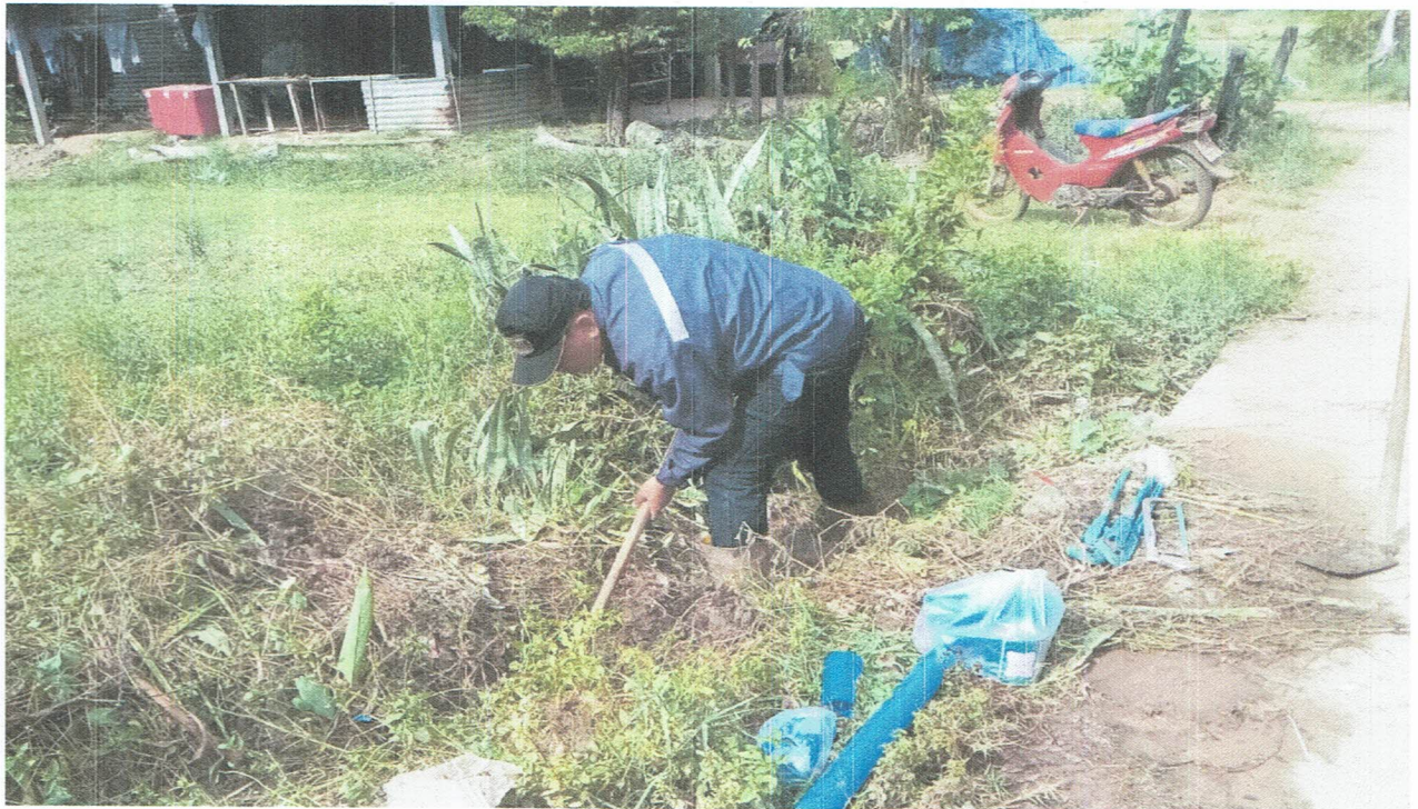
ซ่อมแซมระบบประปาหมู่บ้าน
